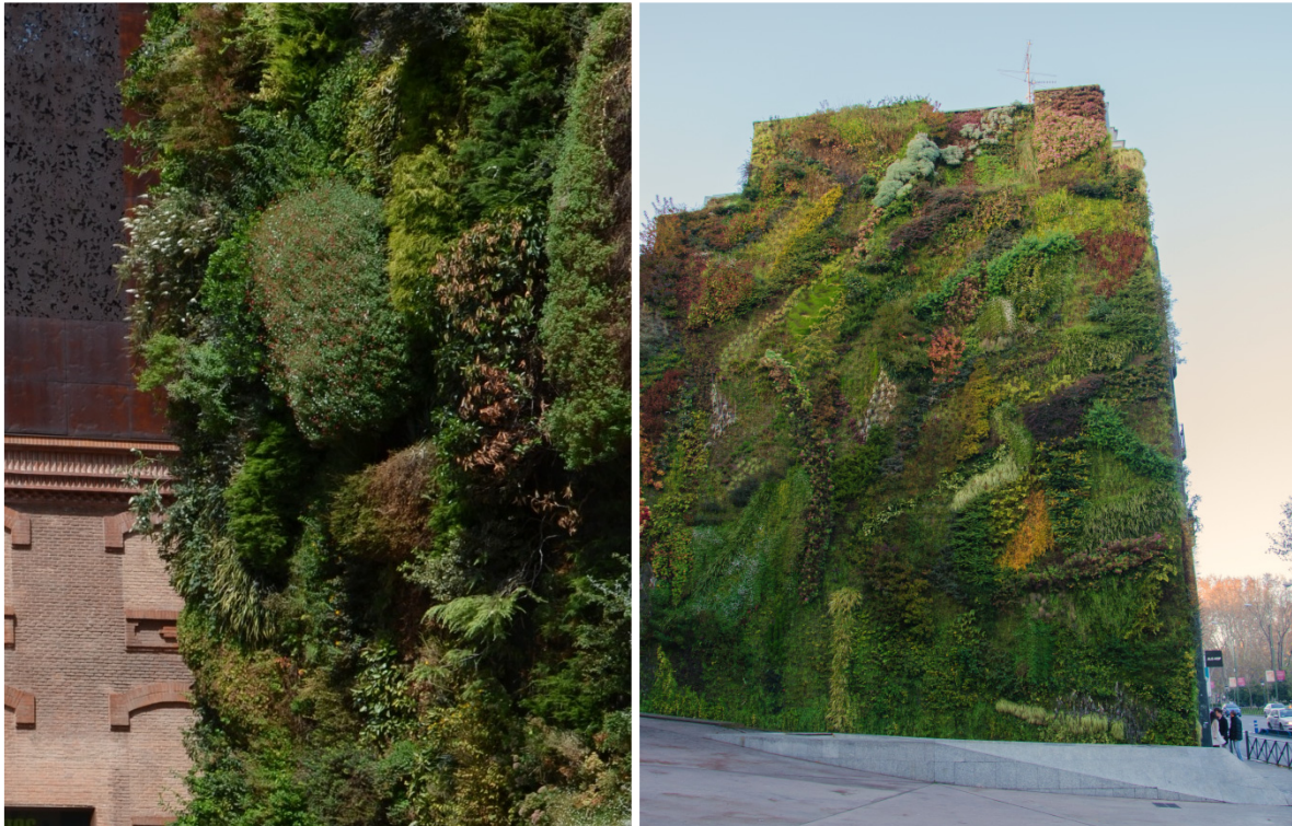
Abbildung 3 Begrünte Fassade des Caixa Forums in Madrid. Die 2007 fertiggestellte intensive Fassadenbegrünung des französischen Botanikers und Gartenarchitekts Patrick Blanc basiert auf einer flächigen Konstruktion aus Polyurethanfolie, Kunststoffgewebe und Filzdecken (Foto © Miriam Brune).
