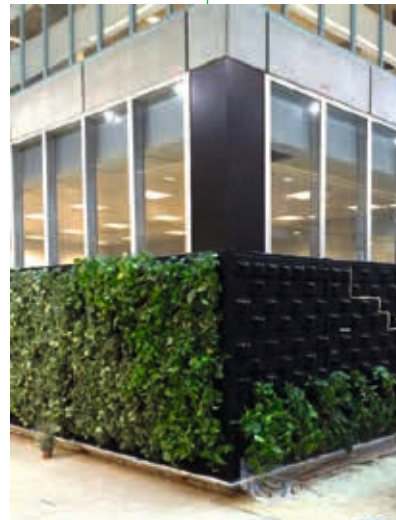
Innenraumbegrünung: Projekt Enexis in Groningen (Niederlande), im Bauzustand
