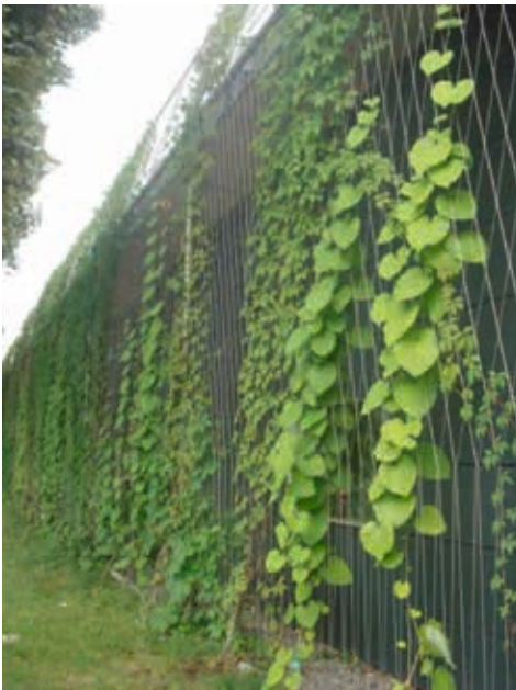
Stahldrahtnetz als flächige Kletterhilfe
